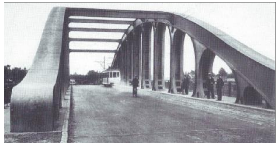
Vue dans l'axe de l'ouvrage (source : Hasselt, een brug meer of minder )
