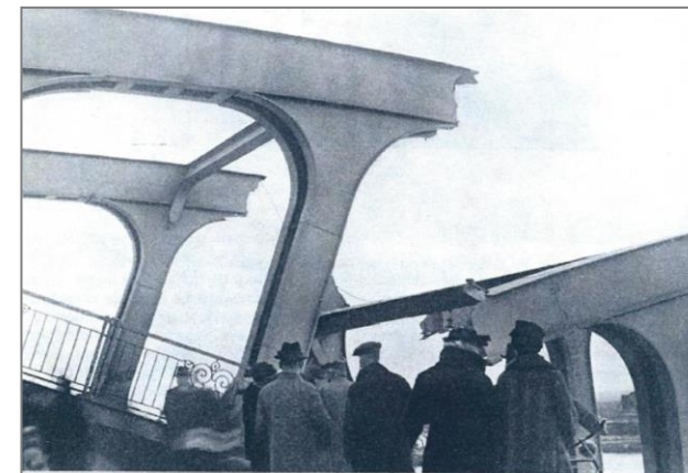
Rupture franche des membrures supérieures (source : Hasselt, een brug meer of minder )
