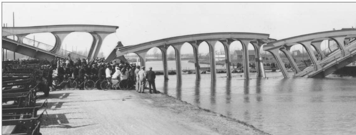
Le pont de Hasselt après son effondrement dans le lit du canal Albert (source : L'Ossature Métallique , n°5, 1938)
