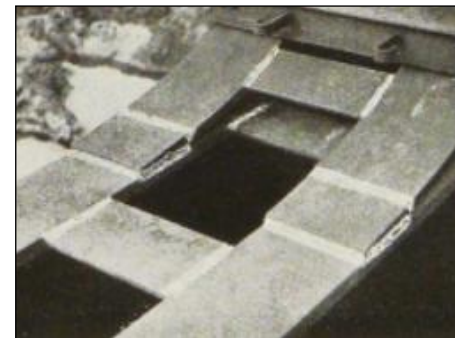
Détail constructif dans la zone d'initiation de la première fissure (source : L'Ossature Métallique, n°2, 1939)
