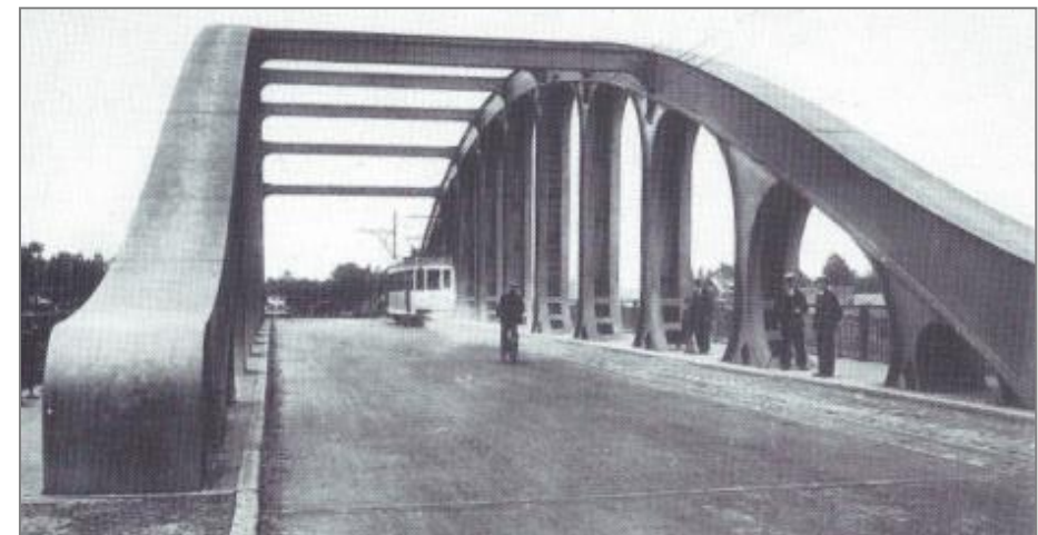
Zicht in de as van het bouwwerk (bron: Hasselt, een brug meer of minder )
