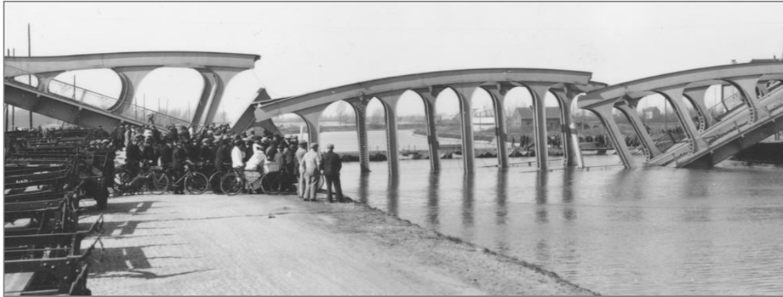
De Hasseltse brug na de instorting in de bedding van het Albertkanaal (uit : L'Ossature Métallique , n°5, 1938)
