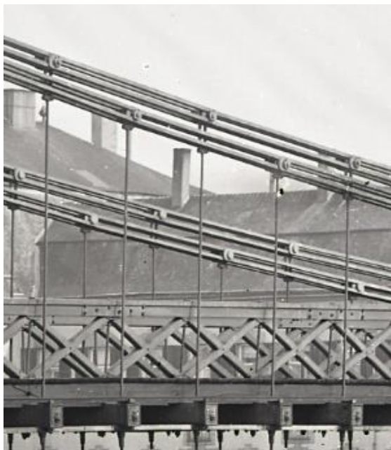
Vue des 4 caténaïres du pont et des suspentes (détail d'une photographie des collections du Musée de la Vie Wallonne, à Liège)
