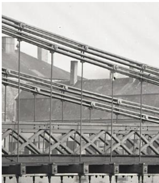
Vue des 4 caténaires du pont et des suspentes (détail d'une photographie des collections du Musée de la Vie Wallonne, à Liège)
