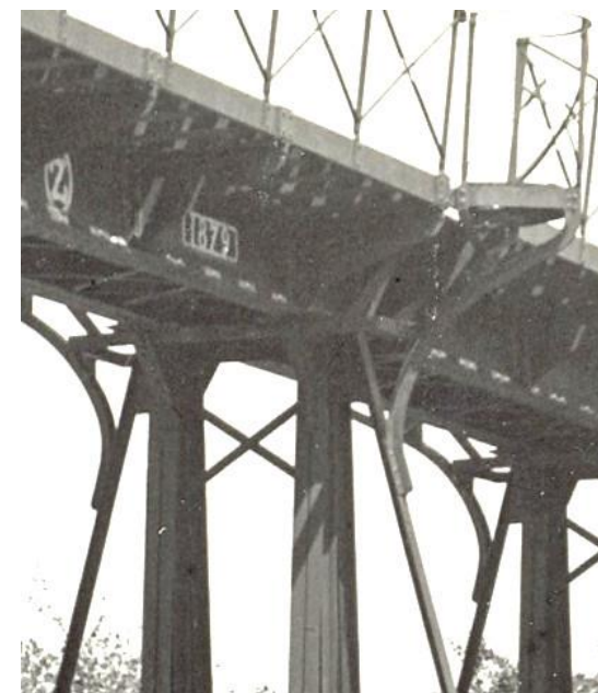
Fig. 1 : Détails du tablier du pont en zone d'appui intermédiaire
