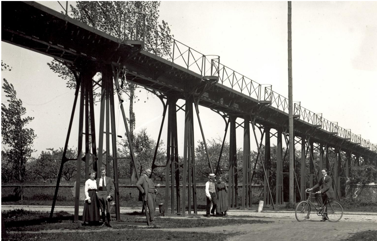
Le pont-rail de Branchon : noter le garde-corps, l'élargissement de la plate-forme au niveau des sections d'appui, les palées tripodes de support et les contreforts de stabilisation transversale (Photo : Félix Gréban de Saint-Germain, Collection Département d'Histoire de l'Université de Namur)
