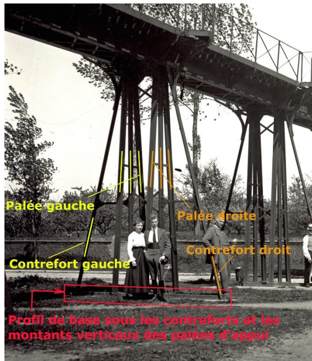
Fig. 2 : Détail d'un appui, les palées supports, les contreforts, et le profil de base principal
