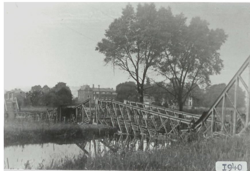
↑ Fig. 9 : Les ruines du pont en mai 1940. (photo collection F. Bonnechère)
