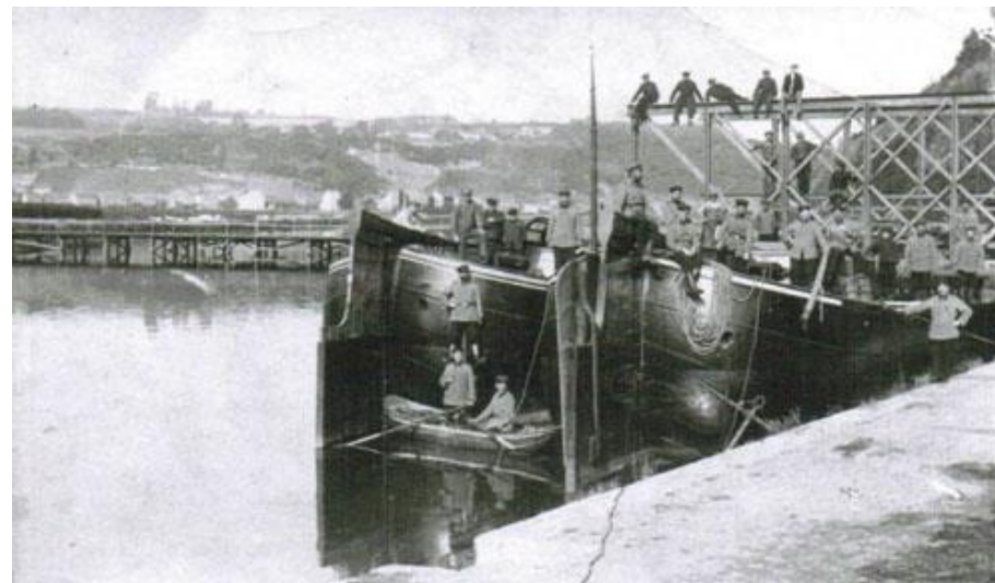
→ Fig. 7 : Élément de la reconstruction du pont en 1914, embarqué sur des péniches (flèche verte à la figure 6). Ouvriers et péniches des ateliers Jabon. On distingue à l'arrière la passerelle allemande en bois. (photo du site quenouvelle.be/Amay 19 )
