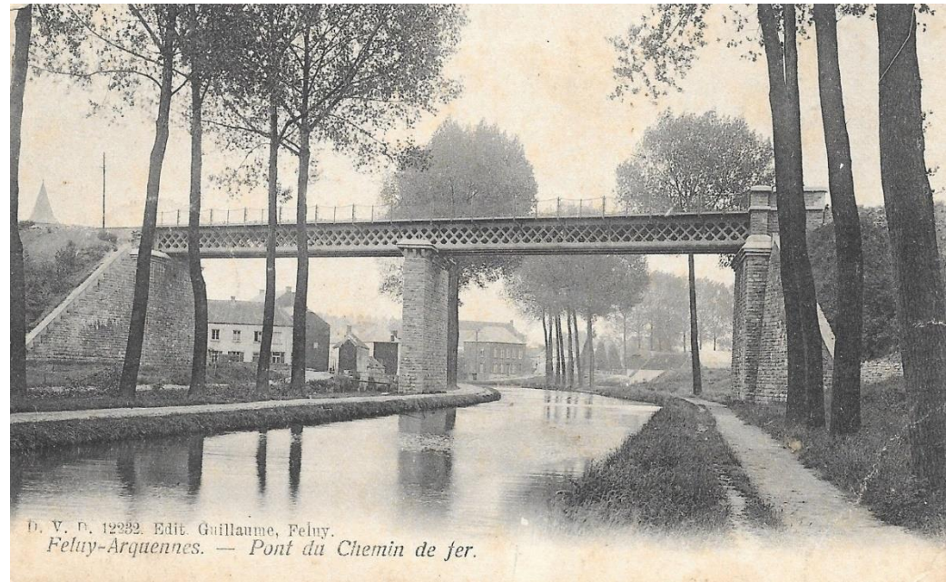
Le viaduc d'Arquennes en 1905 (CPA D.V.D. Édit. Guillaume, Feluy)
