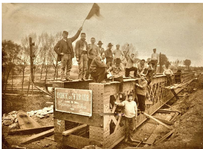
Fig. 5 : reconstruction de 1902 ; structure portante d'une voie ; longueur 52 m (collection privée M. Amerycks).
