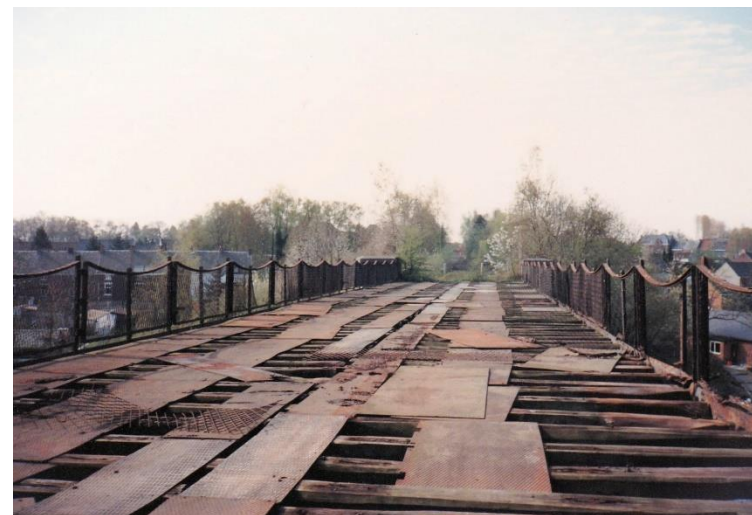
Fig. 9 : Le viaduc sans ses rails, vers 1990 (collection de la Maison de la mémoire de Seneffe)
