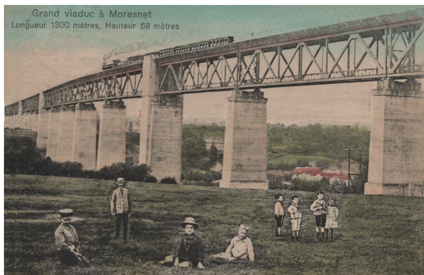
Fig. 2 : Le viaduc de Moresnet vers 1920 (Éd. F. Zinzen, La Calamine)
