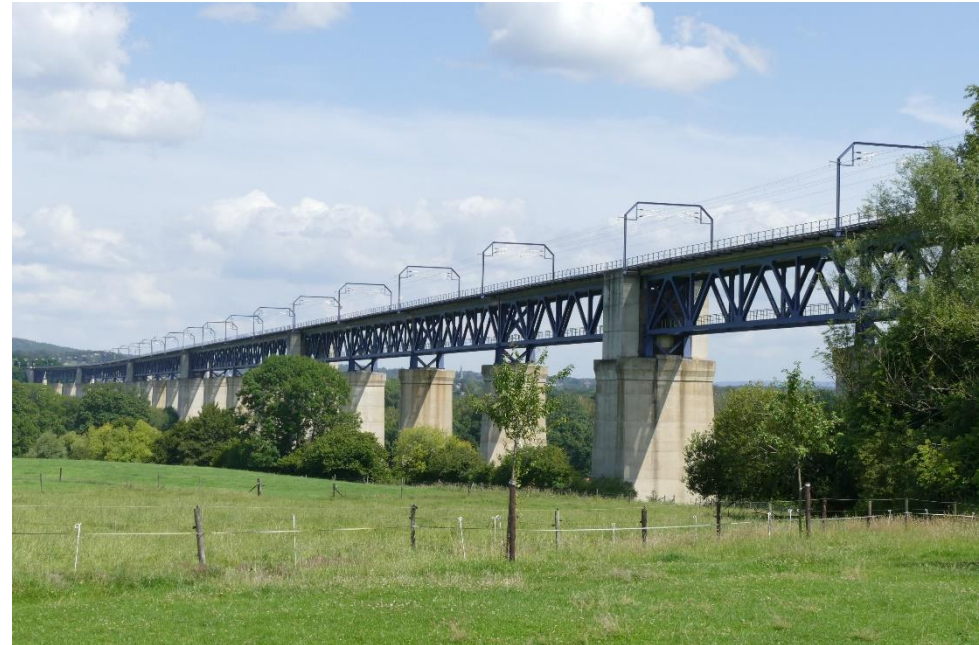
Fig. 1 : Vue de l'actuel viaduc de Moresnet (photo M. Braham, juin 2020)
