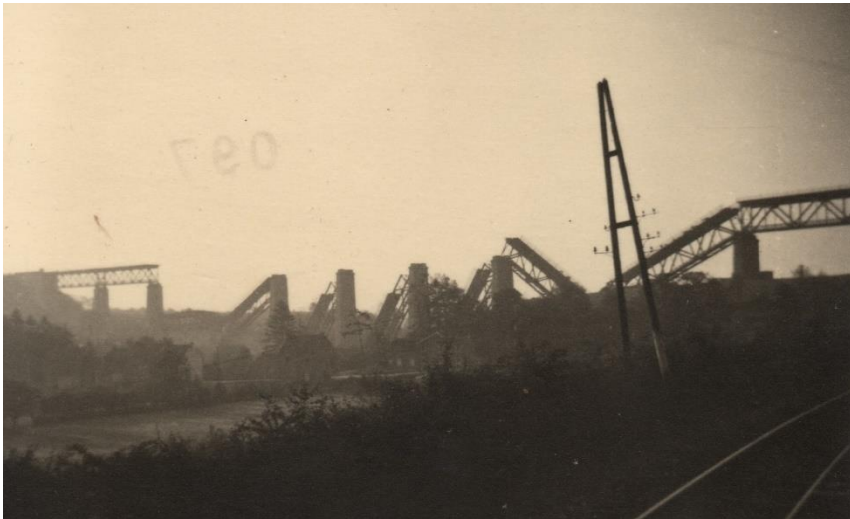
Fig. 10 : Destructions du 10 mai 1940 : à gauche travées 22 et 21 intactes, puis travées 20 à 14 détruites, puis travée 13 intacte. (collection privée G. Colyn).
