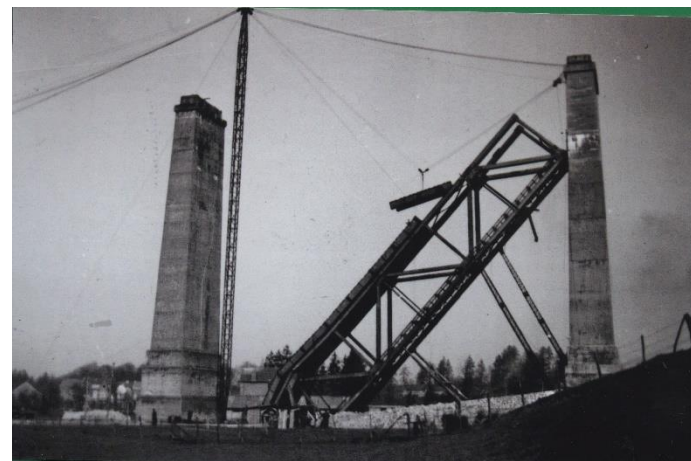
Fig. 13 & 14 : Phases de déblaiement (1945) des tabliers détruits en 1944. Fig. 13 : pile 15. - Fig. 14 : piles 17 (à gauche) et 18. (collection privée G. Colyn)
