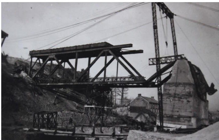
Fig. 13 & 14 : Phases de déblaiement (1945) des tabliers détruits en 1944. Fig. 13 : pile 15. - Fig. 14 : piles 17 (à gauche) et 18. (collection privée G. Colyn)
