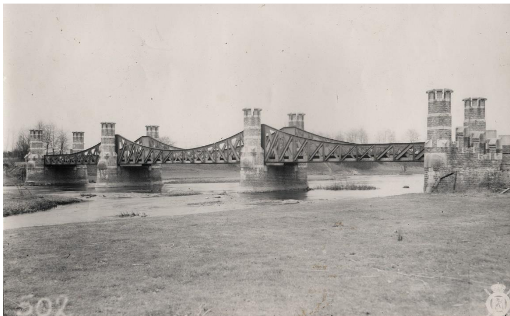
Fig. 2 : Le pont du Breux (Archives de la SNCV)
