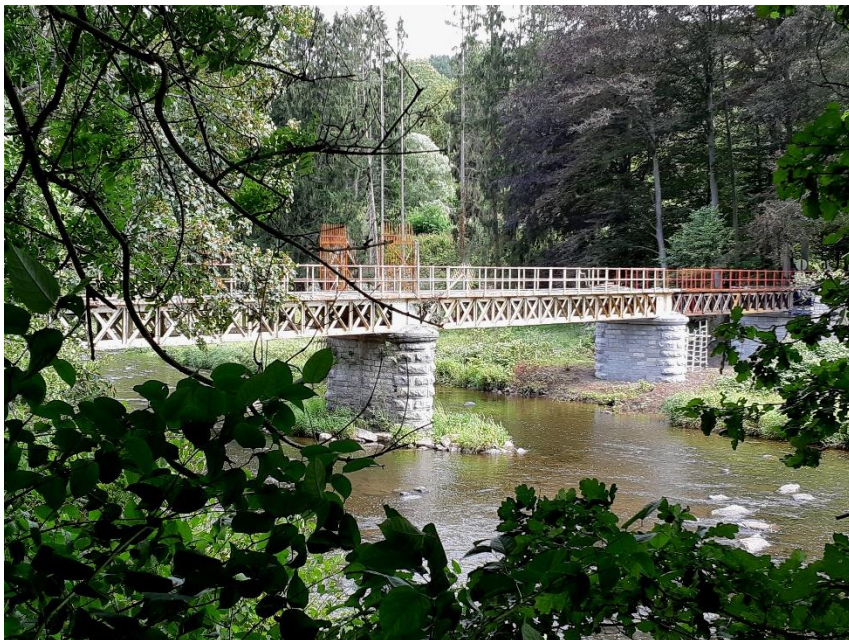
Fig.2 : Vue du pont dans son écrin de verdure (photo M. Braham, août 2020)
