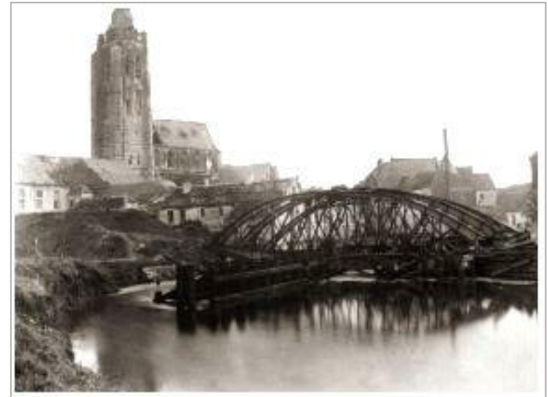
Fig. 3 : Le pont détruit en 1918 (photo d'origine non déterminée)
