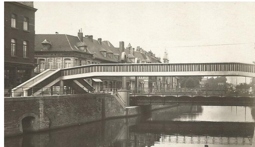
Fig. 14 : La passerelle en béton du pont Notre-Dame , semblable à celle construite en 1937 au pont de Fer (© collection Patrice Delobelle)
