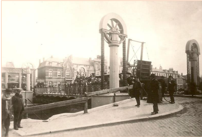
Fig. 12 : Le pont de Fer levant de 1926, en 1926 On aperçoit à l'arrière le pont-levis de 1920 (photo Messiaen 32 )
