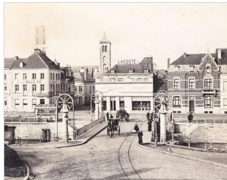
Fig. 7 : le pont levant de 1910, depuis la rive gauche (Détail d'une carte postale : la phototypie belge, BXL)
