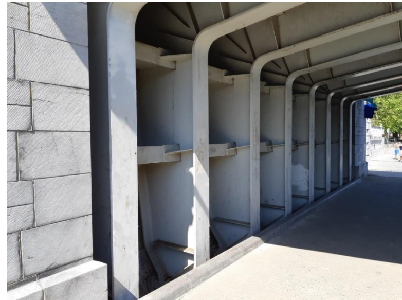
Fig. 20 : Chemin sous le pont en rive gauche ; vue des poteaux des portiques, des entretoises, et des naissances des arbalétriers. (photographie M. Braham, juin 2021)
