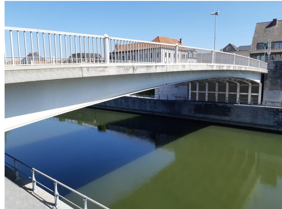
Fig. 1 : Le pont de Fer actuel (Photo M. Braham, juin 2021)
