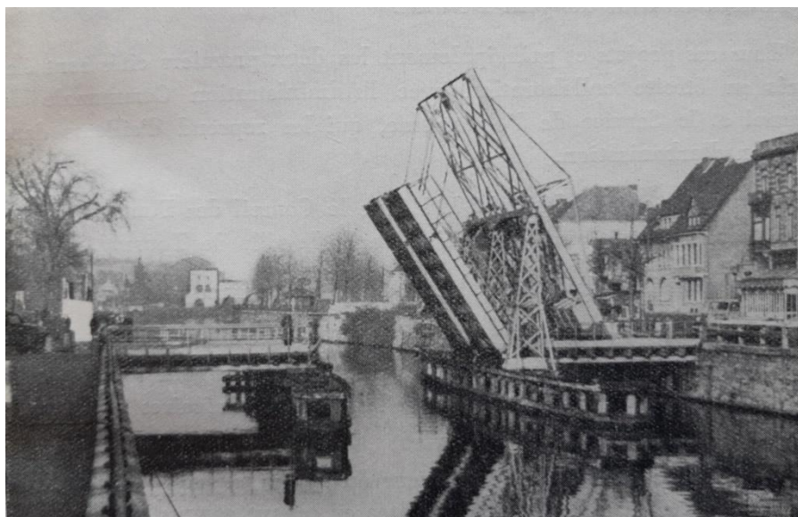
Fig. 15 : Le pont de Fer en version pont-levis, construit en 1940 2 ; à droite l'entrée de la rue Hoyois, au fond le pont des Troues . (Photographie A.T.P.B. 47 , après 1945)
