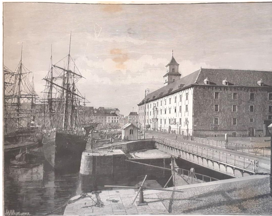
Fig. 3: Het Hanzehuis en de waarschijnlijke opvolger van de oorspronkelijke gietijzeren brug. Links zien we het Grote Dok , rechtsonder, de brug, en verder naar rechts het Kleine Dok . (gravure van F.R.R. Brend'Amour 11 ; waarschijnlijk gedateerd tussen 1860 en 1870).
