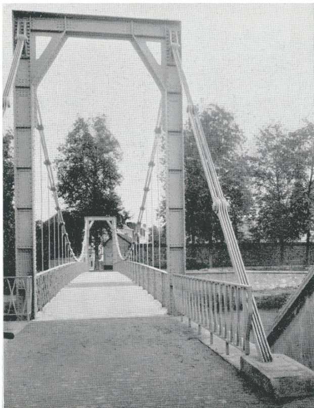
Fig. 6 : Vue des chaînes d'ancrage et des caténaires du pont suspendu (Illustration extraite de la Revue du Nickel 6 )
