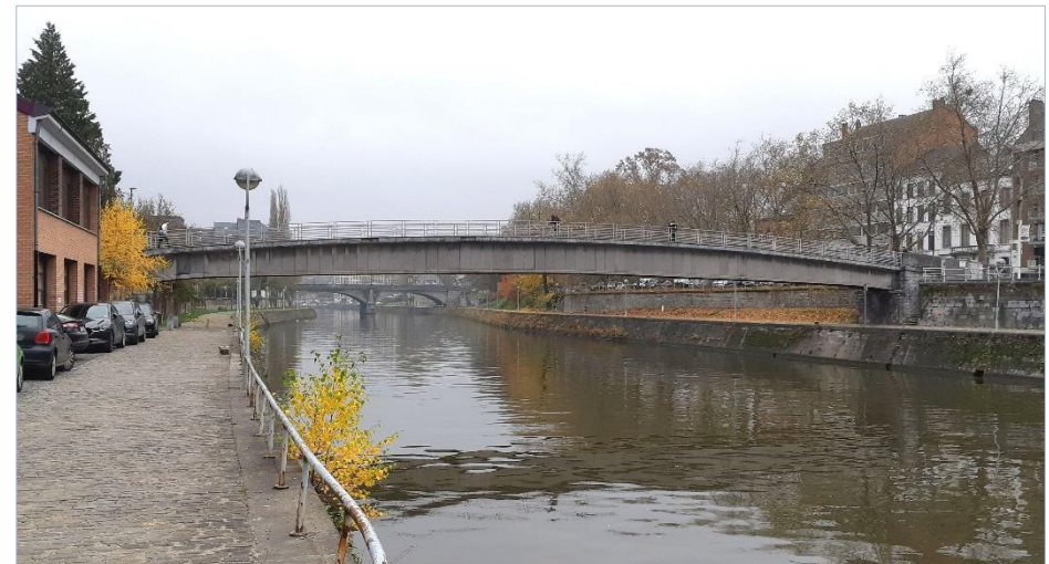
Fig. 5 : La passerelle de 1952, en béton précontraint (photo M. Braham, novembre 2021)
