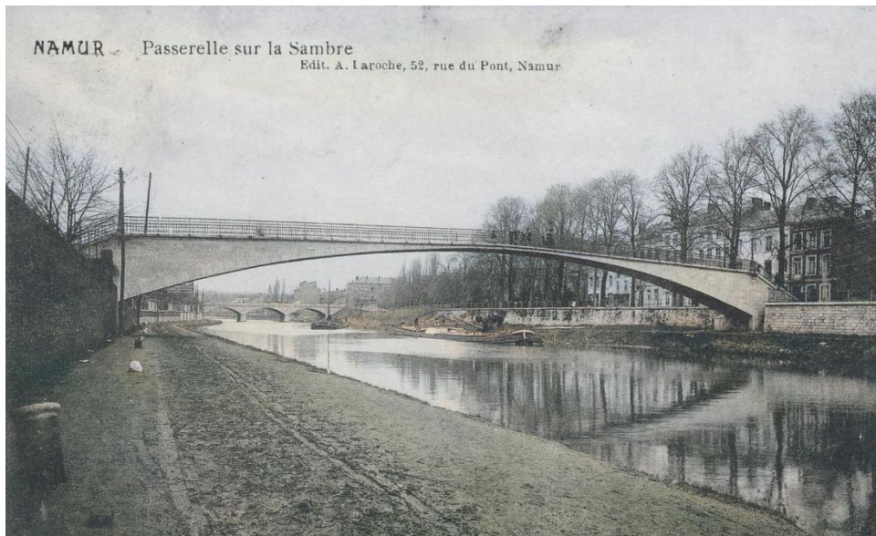
Fig. 2 : la passerelle en béton armé de 1906 (CPA, éditeur A. Laroche à Namur)
