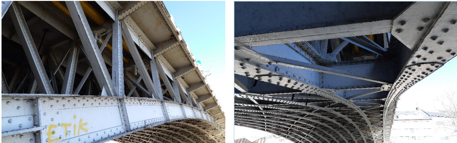
Fig. 9 et 10 : systèmes d'entretoisement du pont de France (photographies M. Braham, février 2022)
