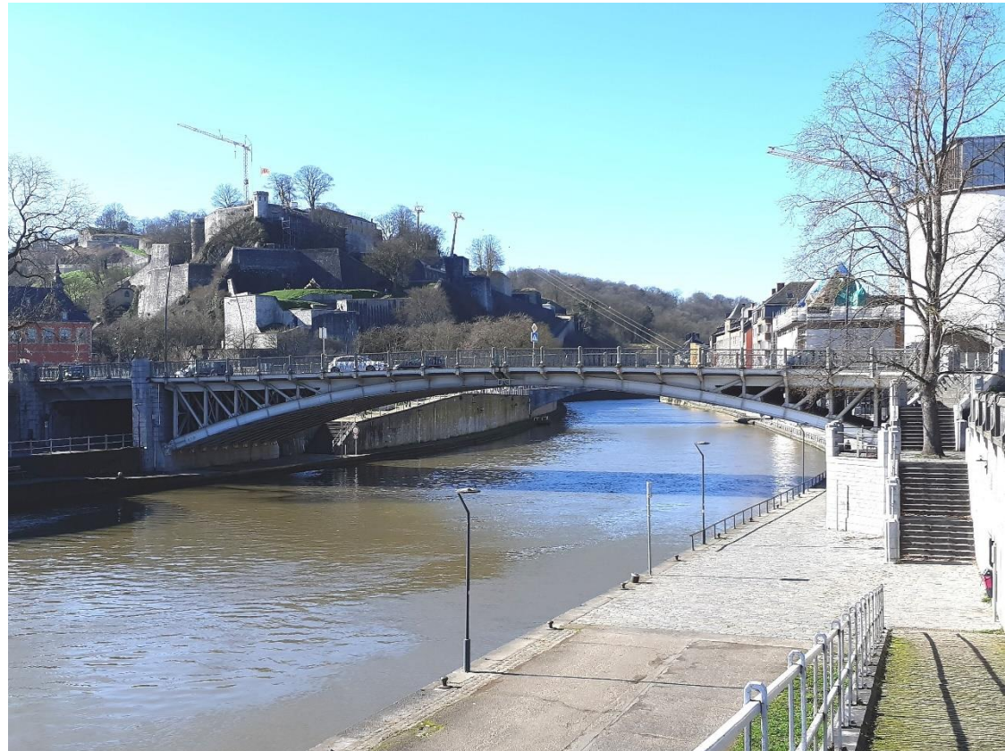
Fig. 1 : Le pont de France actuel (photographie M. Braham, février 2022)
