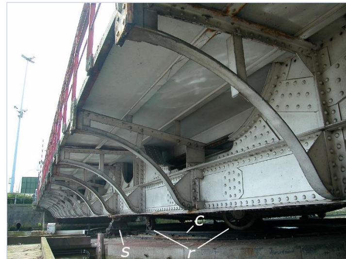
Fig. 12: Aanzicht onder de randbalken van de Scheepsdalebrug (foto © Adriaan Linters voor VVIA 2 , 19.05.2009).
