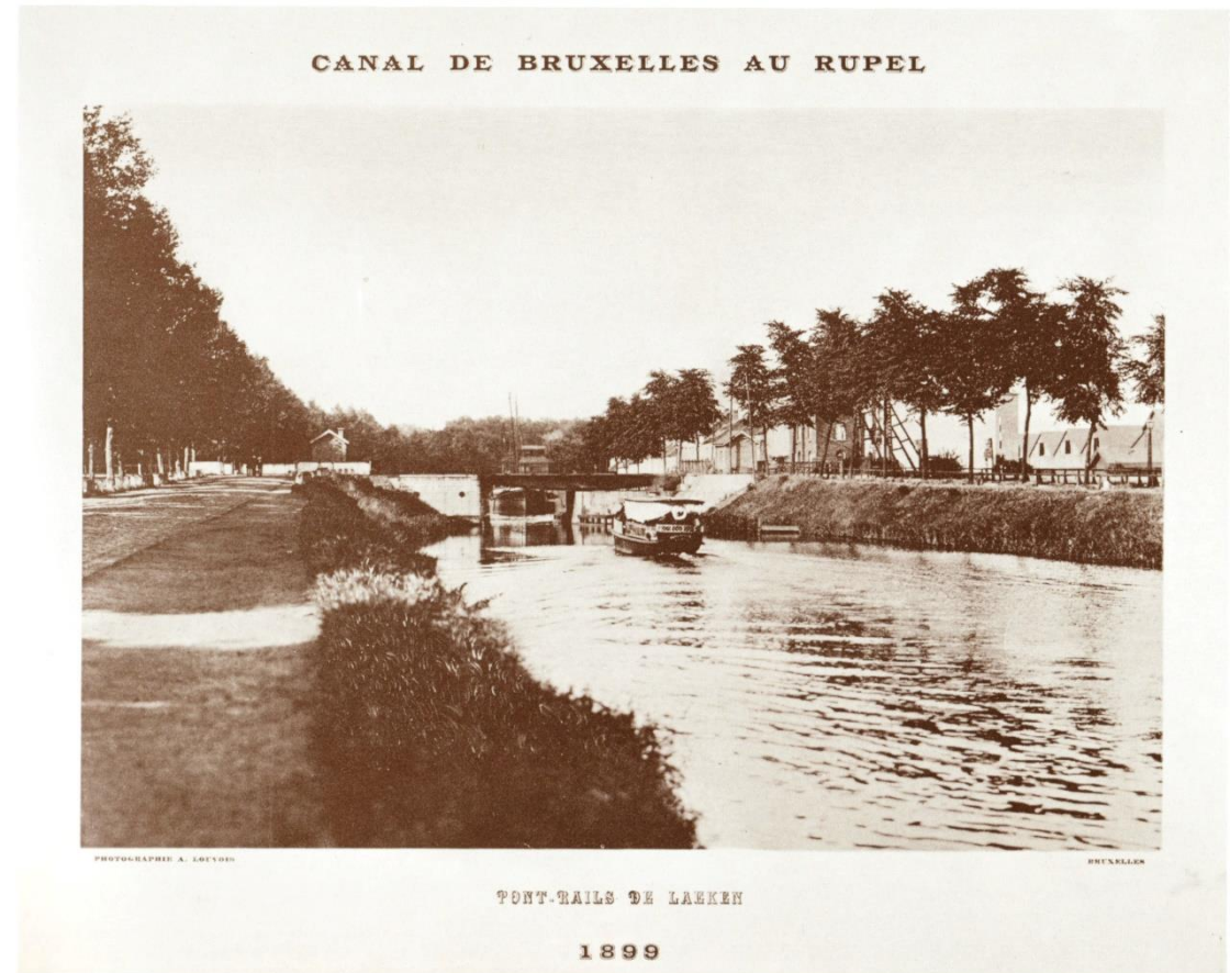
Fig. 1 : le premier pont ferroviaire de Laeken en 1899 (photographie Adrien Louvois, 1899)
