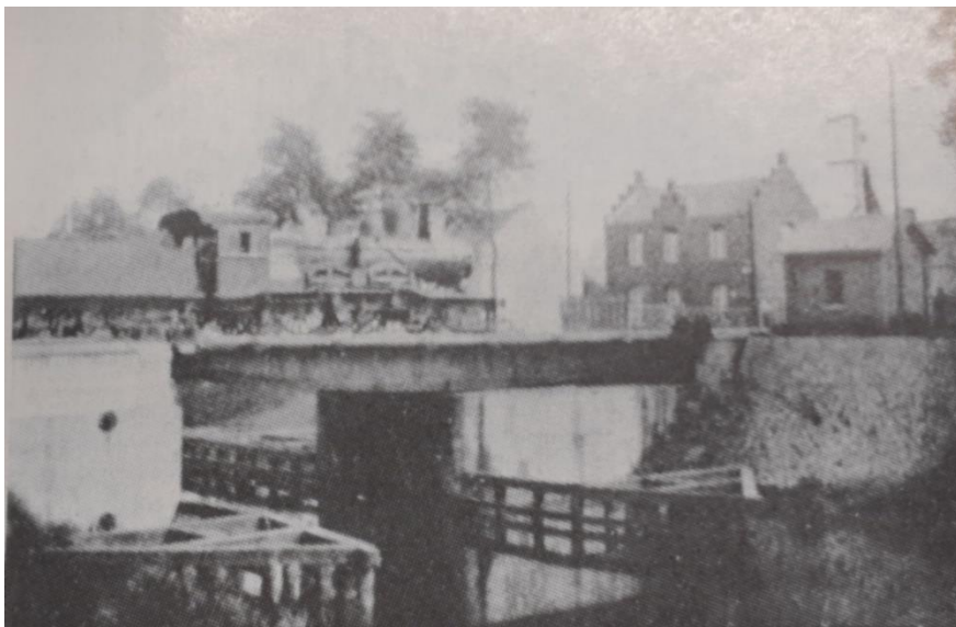
Fig. 2 : Le premier pont ferroviaire (vue de l'amont, date inconnue) (photographie dans Dubreucq 2 , et dans Cosyn 3 )
