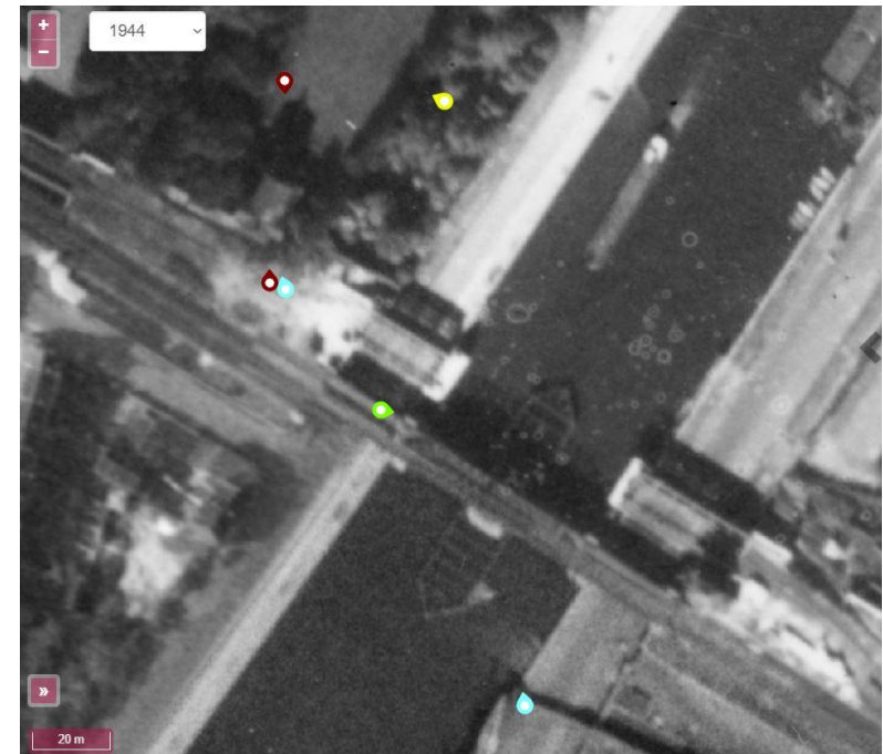
Fig. 10 : Le pont « provisoire » de 1940 et les culées du troisième pont (photo 1944, site internet Bruciel)
