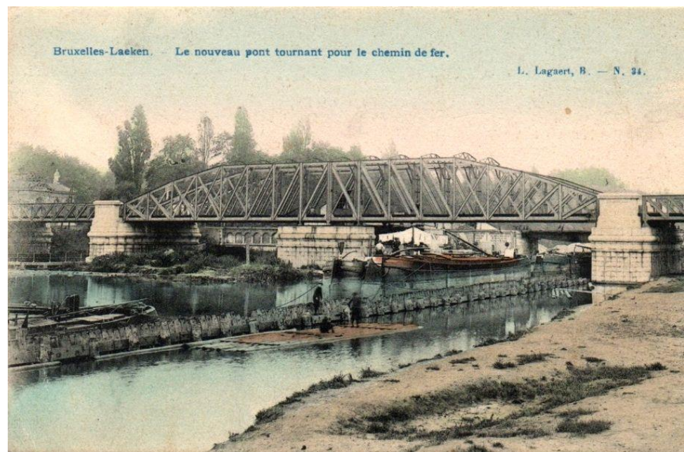
Fig. 4 : le deuxième pont ferroviaire de Laeken en 1905 (carte postale, éd. L. Lagaert, Bruxelles)
