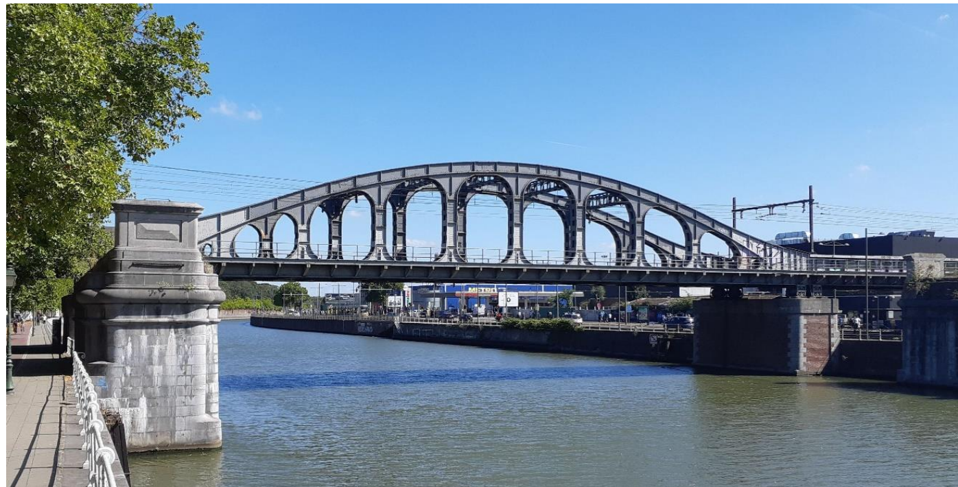
Fig. 14 : Le troisième pont ferroviaire de Laeken (vue d'amont, depuis la chaussée de Vilvorde ; photographie M. Braham, août 2022)
