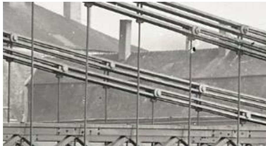
Fig. 5 : Caténaire à maillons de fer (exemple du pont suspendu de Seraing-fiche 10)
