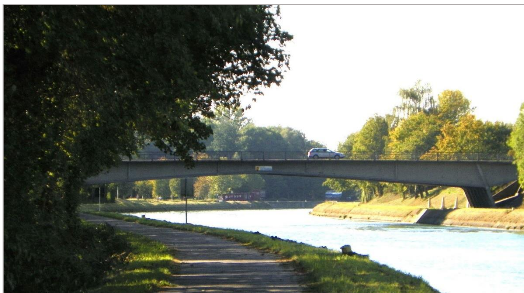
Fig. 6 : Le pont du Vermontois actuel à Péruwelz (photo de B. Van Mol)
