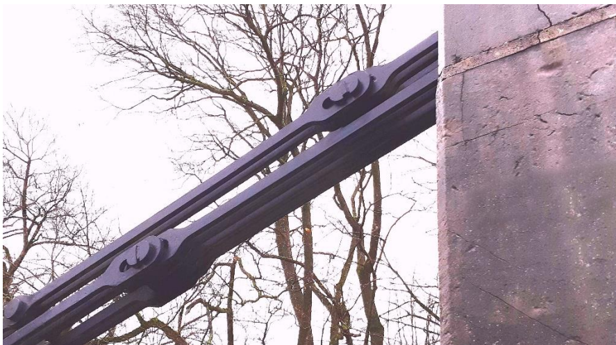
Fig. 4 : Caténaire à barres de fer à œillets (exemple du pont suspendu d'Aywaille-fiche 13)
